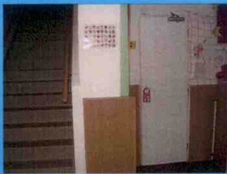
vstupní dveře do kotelný
