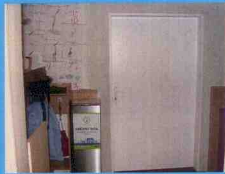
protipožární dveře do kuchyně zařízení
