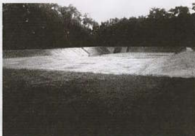
současná podoba betonové nádrže
